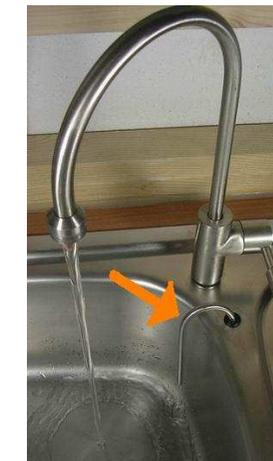
Um eine dauerhafte Verbindung zwischen der Osmoseanlage (Spülwasserausgang der Osmosemembran) und dem Siphon zu verhindern, wird das Spülwasser über einen kleinen, separaten Edelstahlauslauf frei in das Spülbecken geleitet. Trinkwasserleitung und Abwasserleitung bleiben somit getrennt.
